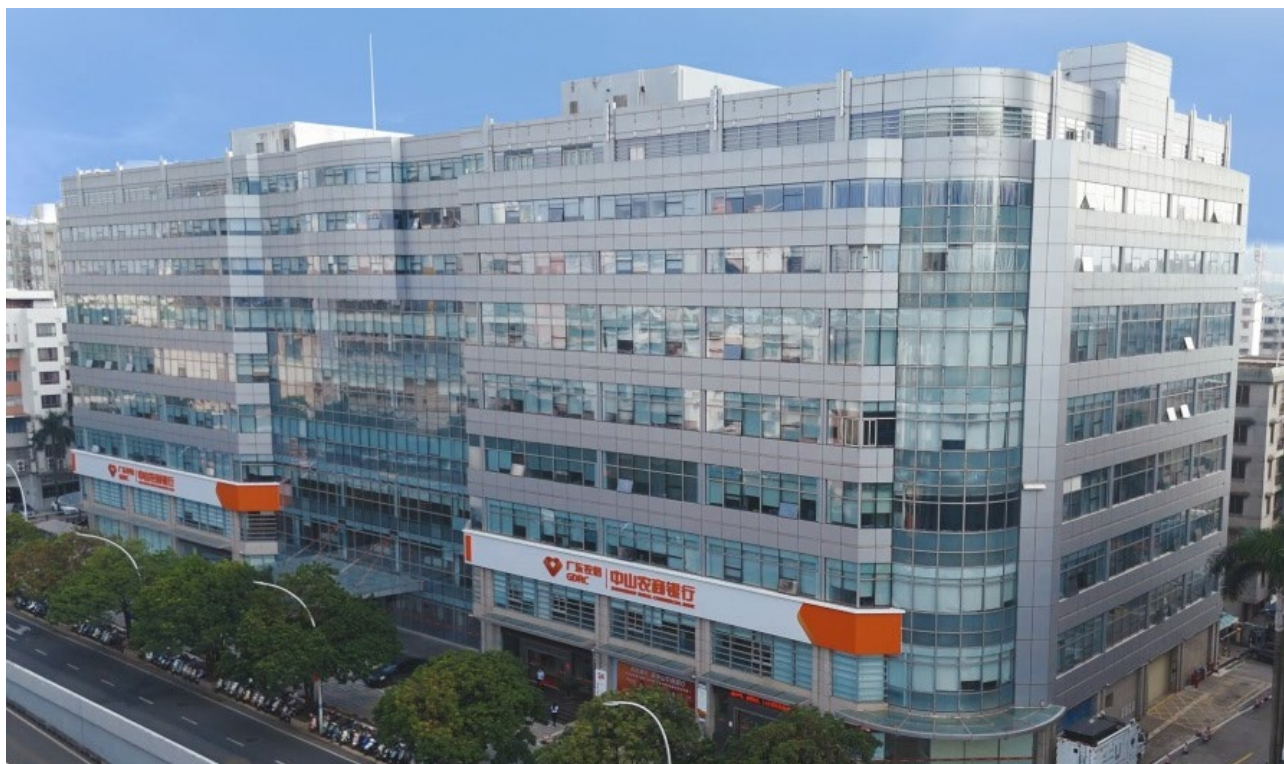
中山农商银行总行大楼
